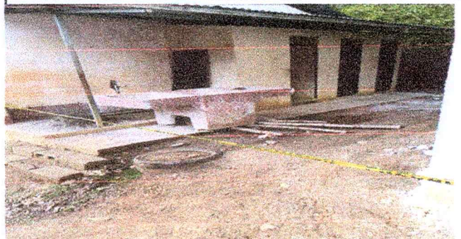
Foto 4: COLOCACIÓN DE PISO CERAMICO Y RELLENO DE CISAS
