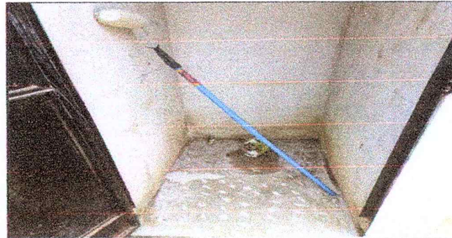
Foto 6: SUSTITUCIÓN DE PISO CONCRETO POR CERÁMICO Y CERNIDO POR AZULEJO
